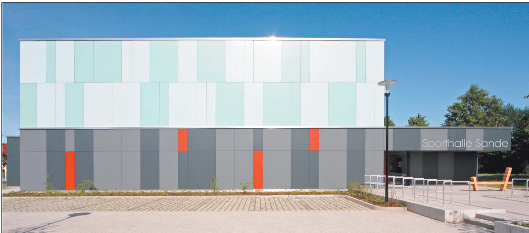
Die neue Sporthalle in Sande: Optisch attraktiv und energiesparend gebaut. Die Passivhaustechnologie wurde hier überzeugend angewandt.
